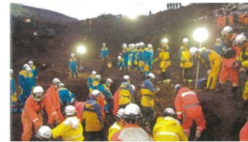
高野台(南阿蘇村)の崩落現場 <熊本地震>
